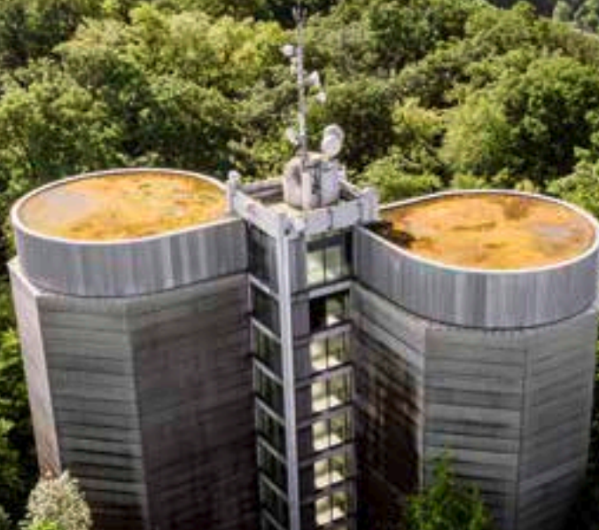
Der Wasserturm Hartwald aus der Luft.
