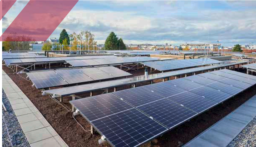
Das neue Dach der Maicklerschule wird mit der späteren Begrünung unterhalb der Konstruktion (links) und PV-Anlage ein starkes Multifunktionalent.
