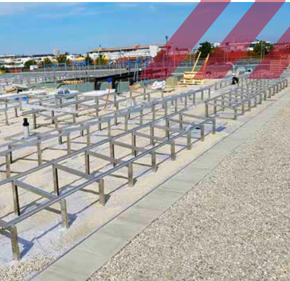
Das neue Dach der Maicklerschule wird mit der späteren Begrünung unterhalb der Konstruktion (links) und PV-Anlage ein starkes Multifunktionalent.
